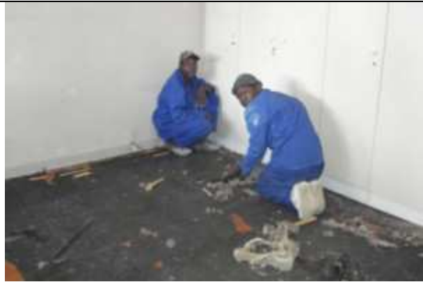
Les travaux de rénovations ont commencé le 25 mars 2009.
