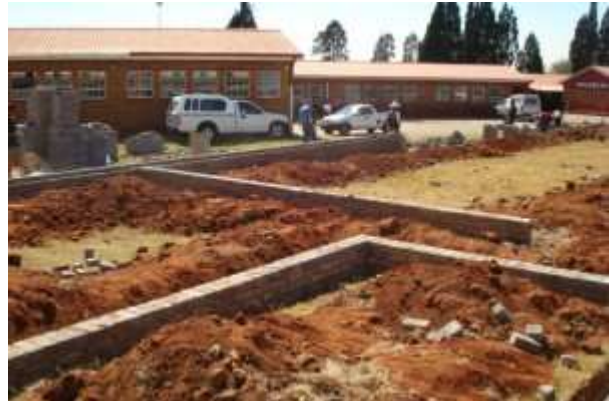
Les travaux de constructions ont commencé le 14 avril 2009.
