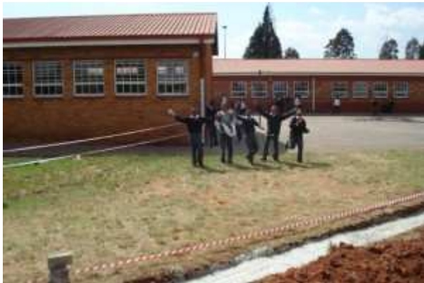
La mise en place du projet a été entamée. Ecole primaire de Mogobeng.
